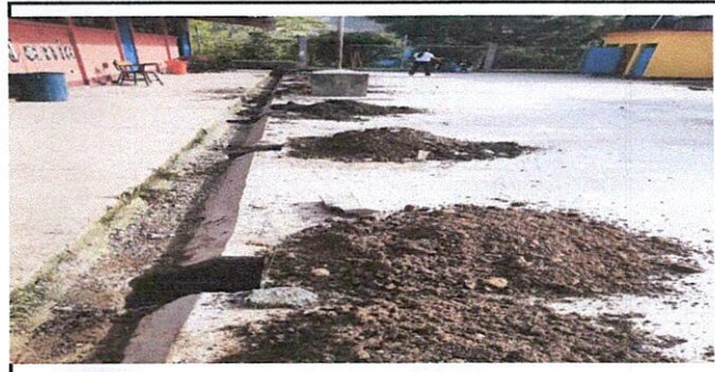
Foto 2: CONTINUACION DE DE LA ESCABACIÓN DE LAS BASES DE COLUMNAS PARA ENTECHADO.
