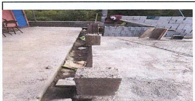
Foto 5: YA ARMADAS Y FUNDIDAS LAS COLUMNAS DE LAS BASES DEL ENTECHADO.
