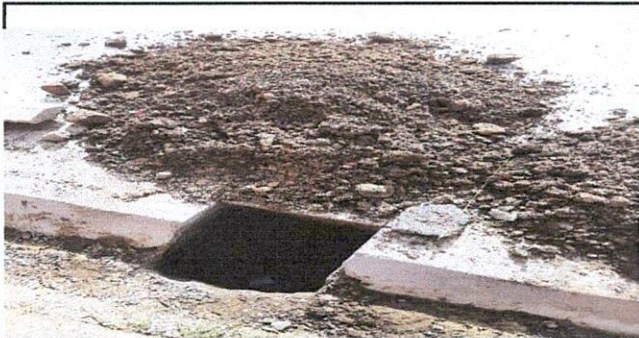
Foto1: SE INICIO HACIENDO LOS TRABAJOS FR BASES DE COLUMNAS PARA ENTECHADO DE 85 DE PROFUNDIDAD POR 50 DE ALTURA.
