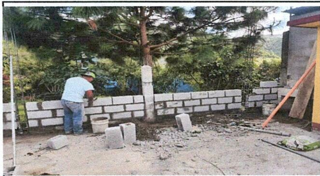
Foto 3: SE INICIO CON EL LEVANTADO DE MURO PERIMETRAL
