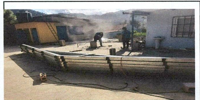
Foto 6: HECHA DE LAS TIJERAS DE METAL PARA EL ENTECHADO DE 9 METROS DE LARGO POR 150.
